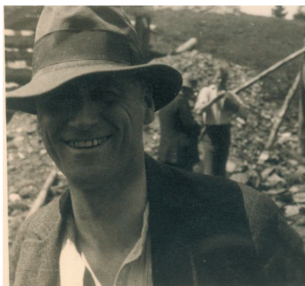
Pierre Céréssole sur un chantier du service civil international (Feldis, 1927)
